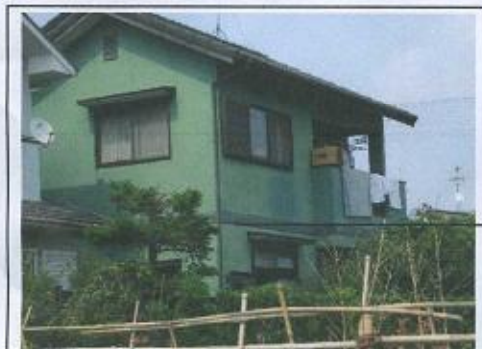
南面・西面全景写真
