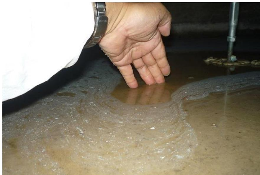
**本件建物の床下（全般）では、写真のように汚水が新築時より3年以上滞留し続けており、入居者は健康的にも不衛生な状態が強いられている。**
