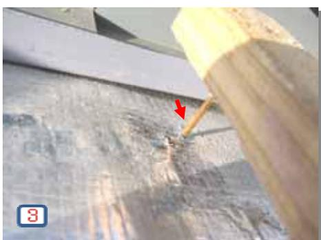
③の写真では、瓦止め棧木の止め付けとして鉄釘（数百本）がアルミ製遮熱シートにこれも屋根全般に打ち込まれている。
