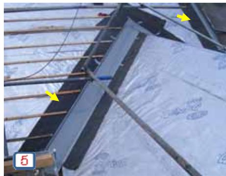
\*ステップル；右写真の②に示す矢印のアルミシートの止め金具
