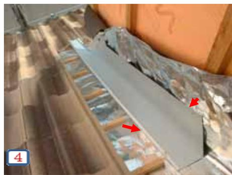
⑤の写真は適切な施工例として谷板金等の取り付けに際し、緩衝材が設置されている状態を示す。
